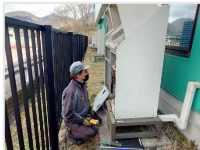
定期点検の様子
