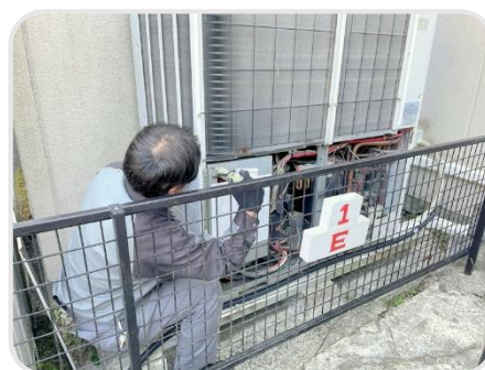
定期点検の様子
