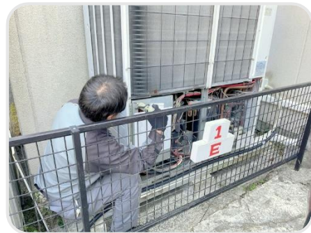
定期点検の様子
