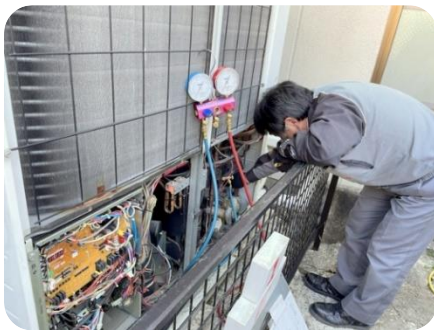
定期点検の様子
