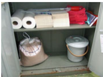
灯油タンク脇への流出・拡散防止用品の設置
